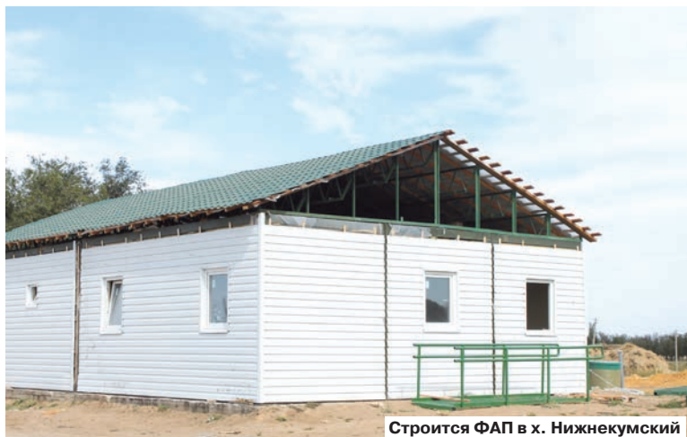
Строится ФАП в х. Нижнекумский
